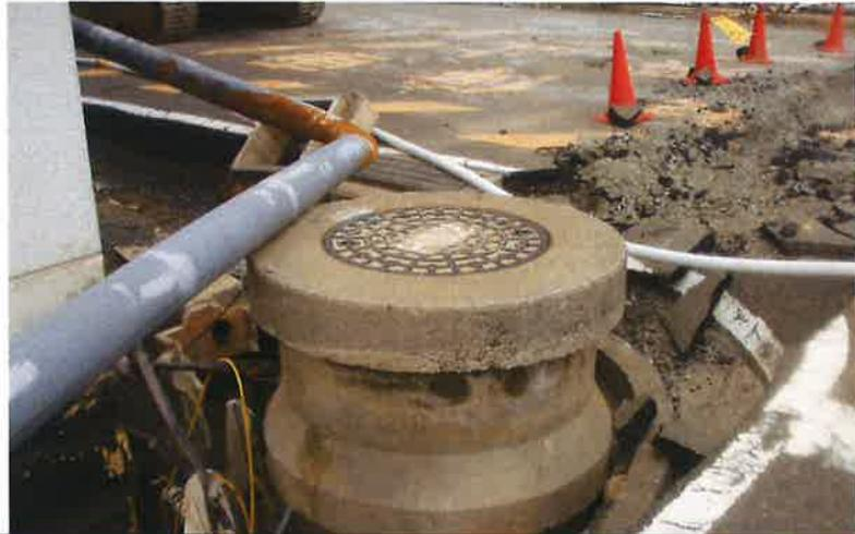
埋立て地盤では、地震動により主に液状化による著しい変形が発生し、変形に伴う管路やトレンチ等の損傷が汚染水漏えいの原因となった可能性が高い。
